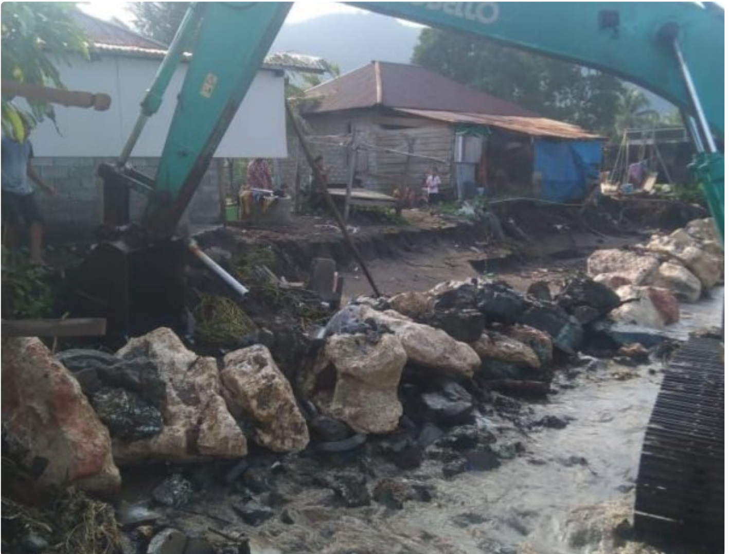
Proyek pemecah ombak di desa kolono
